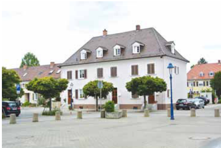
Sanierung so teuer wie Neubau: Häuser der Genossenschaft in der Wotanstraße und am Freyaplatz.
